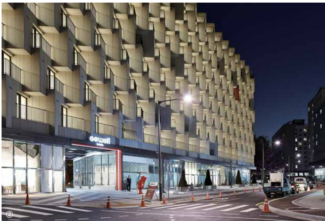
①② •공사명 : 강남 지웰홈스 •주소 : 서울특별시 강남구 자곡로 204-5 •설계 : 정림건축
